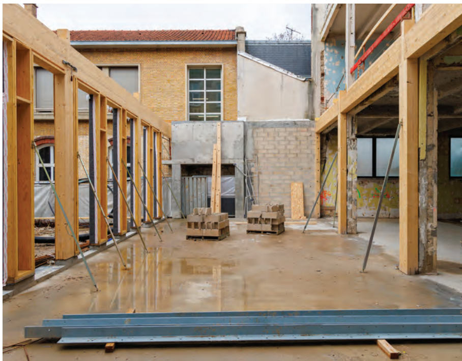
Travaux Rabelais / Delerue
