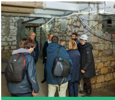
Les travaux de création de la Maison des seniors au 61 place Jules Ferry
