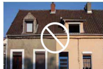
La lucarne d’origine a été remplacée par une lucarne plus large que haute. La cohérence de l’ensemble est rompue.
