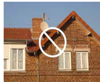
Baies réduites pour recevoir des menuiseries standard
