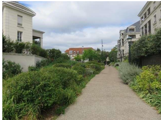
Aménagements extérieurs continus
